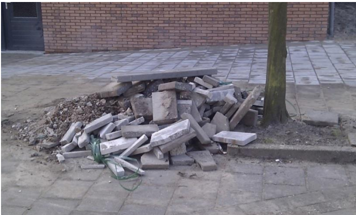
Afb 7. Schade aan boom door storten van puin
